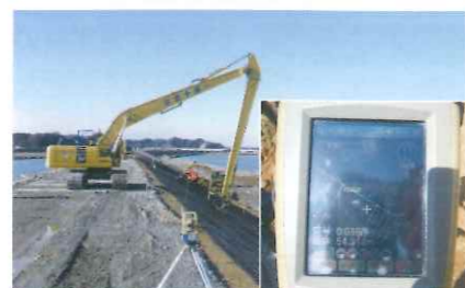
「E三・S」(3DMG:3次元マシンガイダンス)ではオペレーターが画面を確認しながらバックホウを制御
