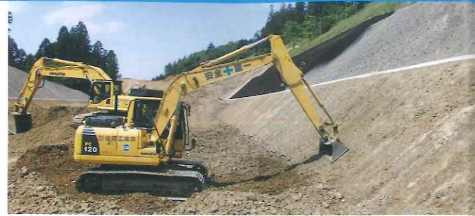
バックホウによる法面整形
