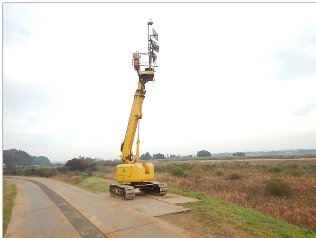
ミルモット設置状況
