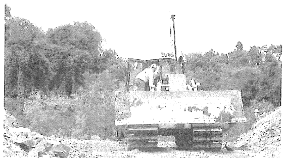
丁寧な指導の下、ブレード操作にチャレンジする生徒（佐藤工務店の現場）
