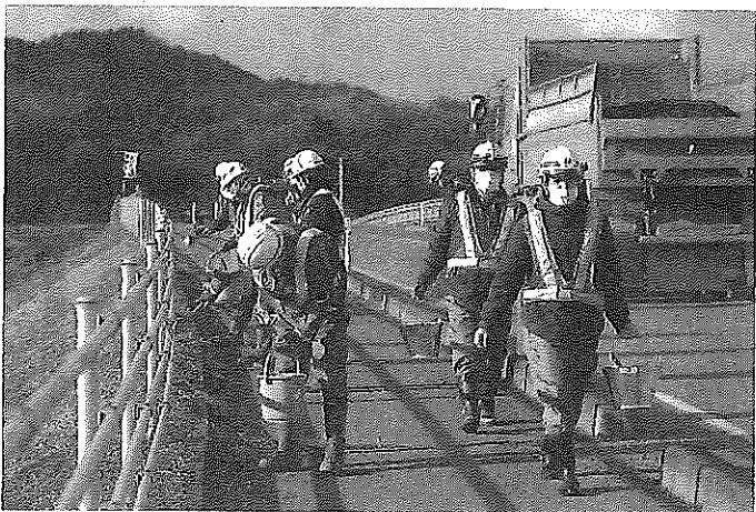
ガードパイプなどの水洗いは散水車からバケツに給 水しながら、一本一本丁寧に汚れを落とした
