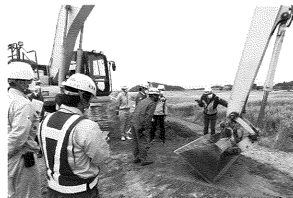
ロングアームバックホウによるICT工事
